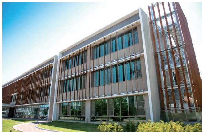
3月末に竣工した附属図書館の外観(右側の建物)
