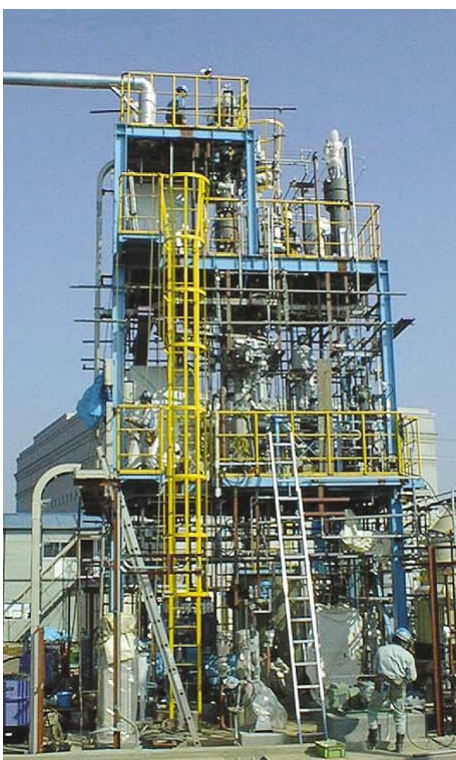
超臨界水を用いるダイオキシン分解プラント
