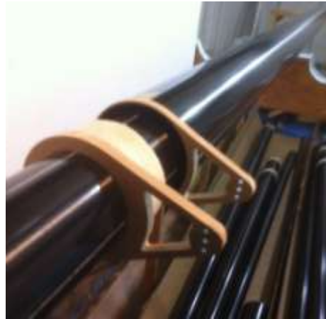
Picture.3 桁接合部のフランジ
