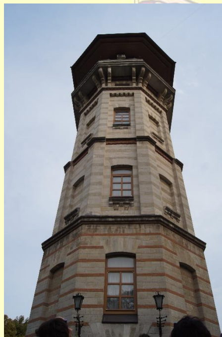
博物館(旧給水塔)
