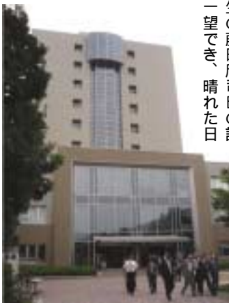
完成した総合研究棟
