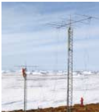
昭和基地でのアンテナ工事
